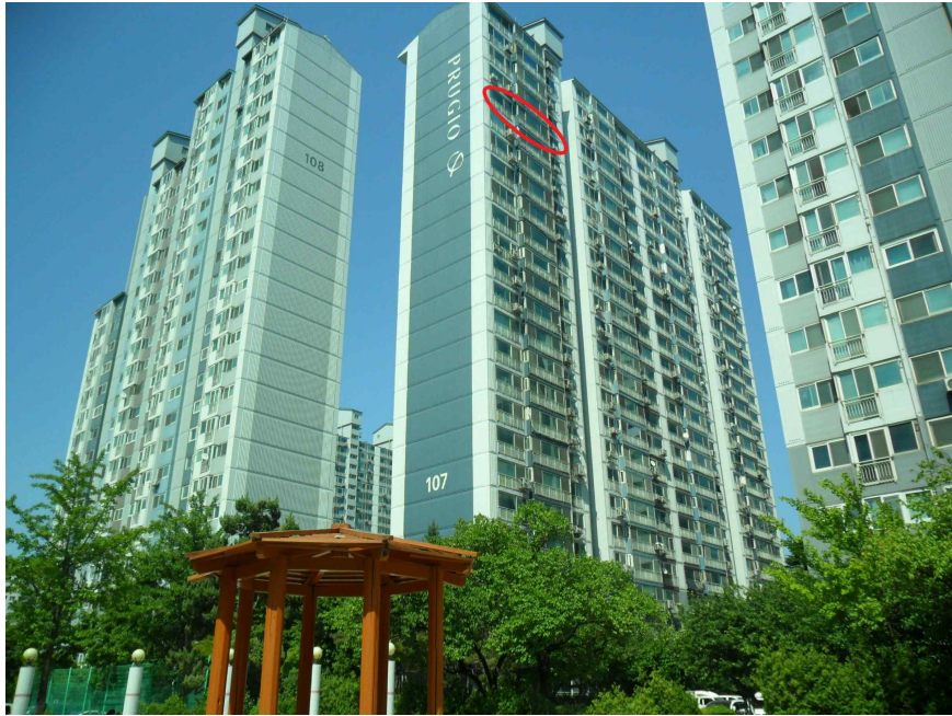
대상물건 전경 (남서측에서 촬영)
