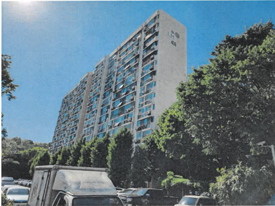
[ 본건 아파트 건물 전경 ]
