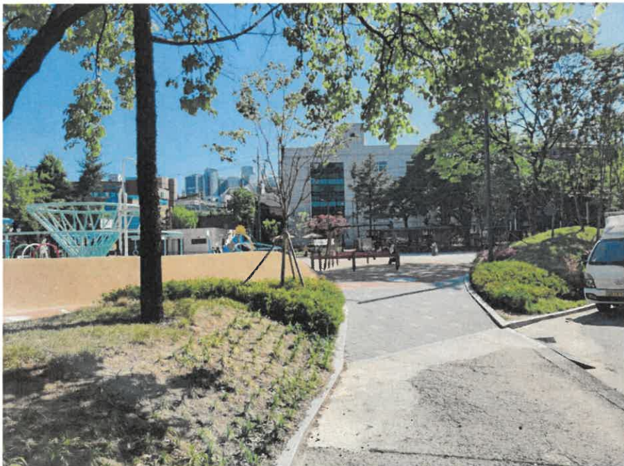
[ 본건 아파트 건물 전경 ]
