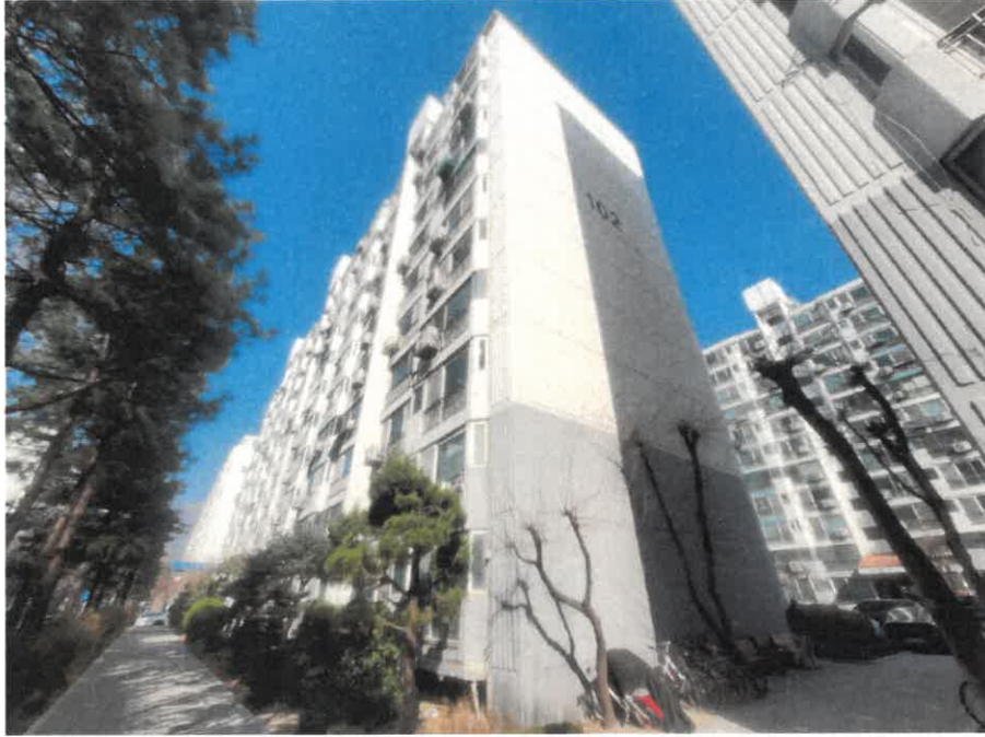
[ 본건 아파트 건물 전경 ]
