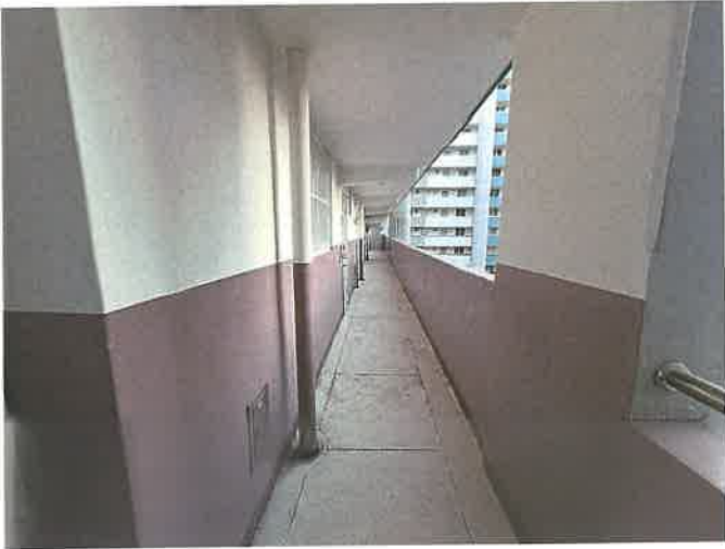
본건 제6층 복도 전경
