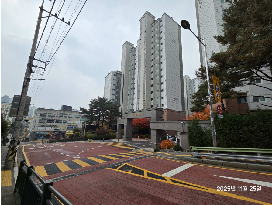
【 본건 단지 전경 및 접면도로 】
