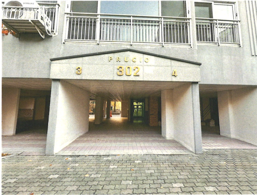
본건 소재 건물 공동출입구
