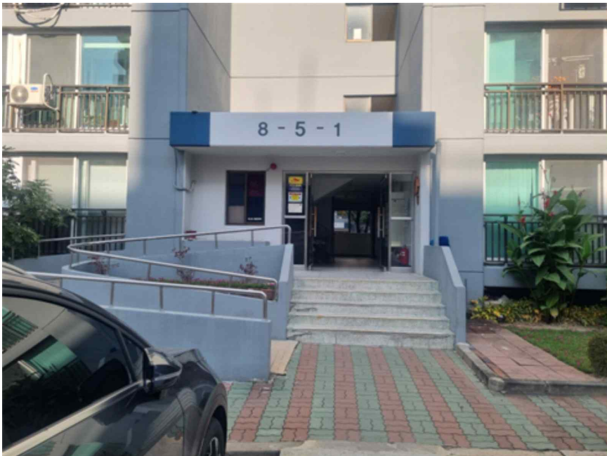
[ 1층 공동 출입구 ]
