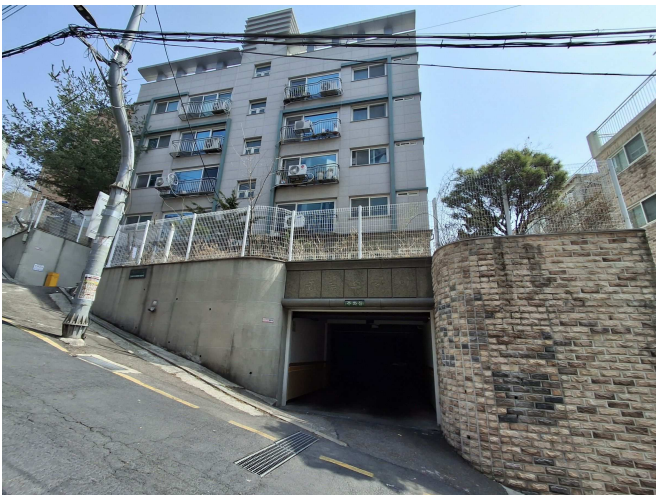
건물 전경 및 지하주차장 입구
