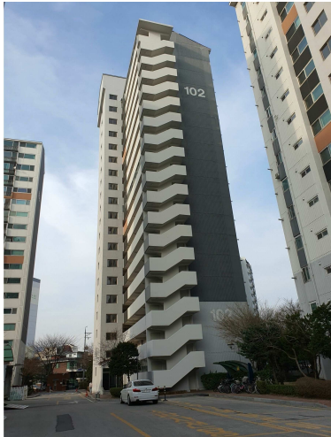
본건 건물 전경
