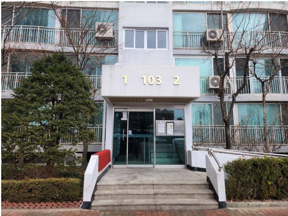
본건 1층 출입문
