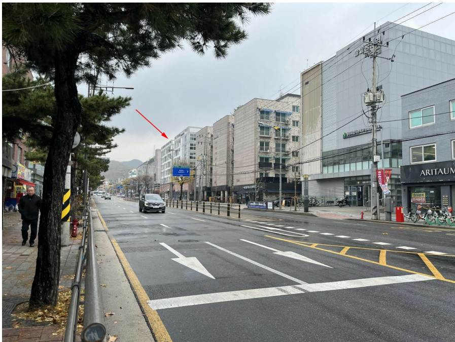
본건 주위 전경 - 남서측에서 촬영
