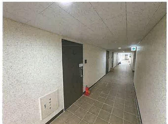
본건 제4층 복도 전경
