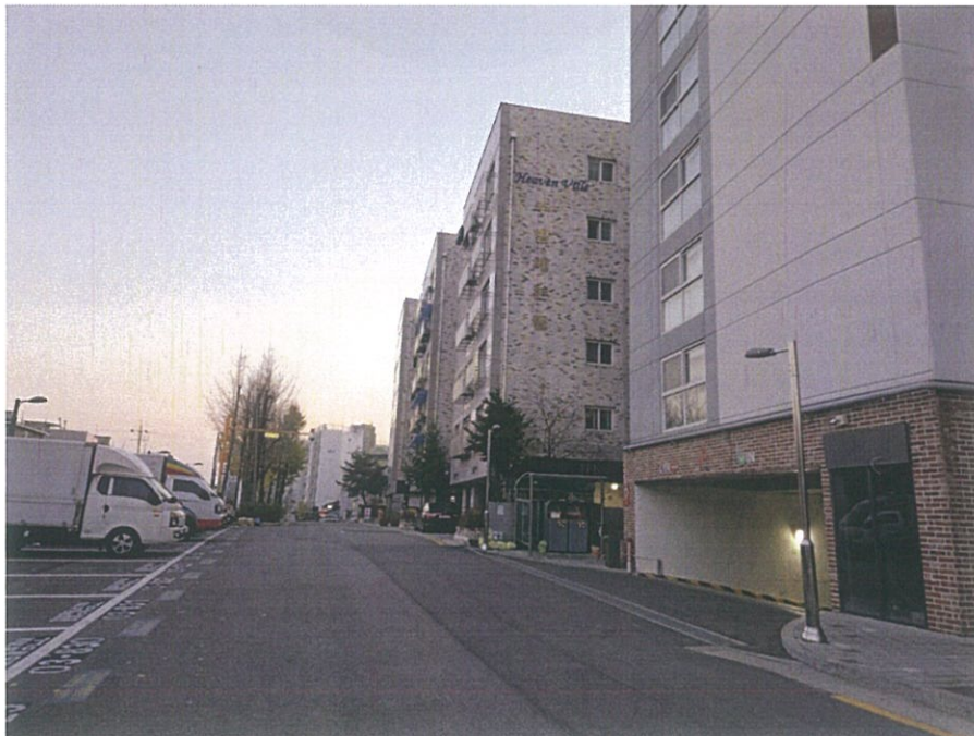
본건 에드가쌍문 동측 주변 전경
