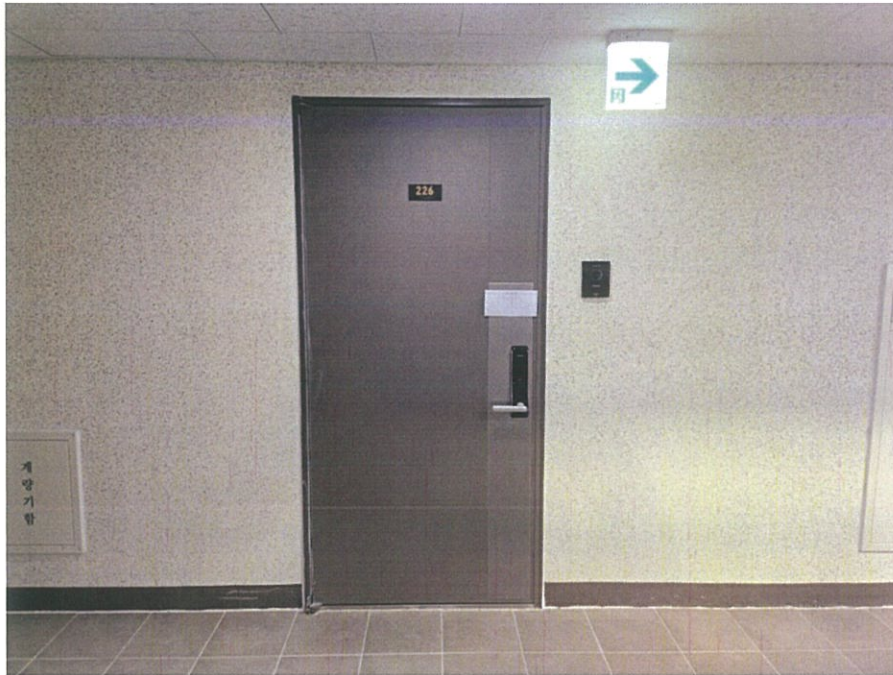
본건 에드가쌍문 제2층 226호 입구 전경
