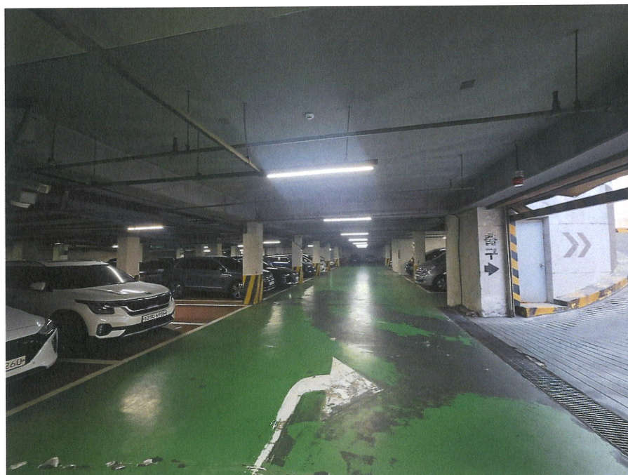
본건 단지 지하주차장 전경
