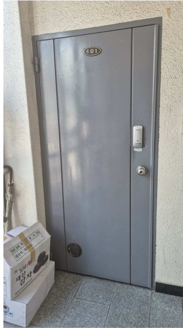
본건 4층 401호 출입문 모습
