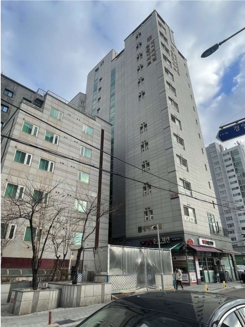
본건 소재 건물 북서측 전경
