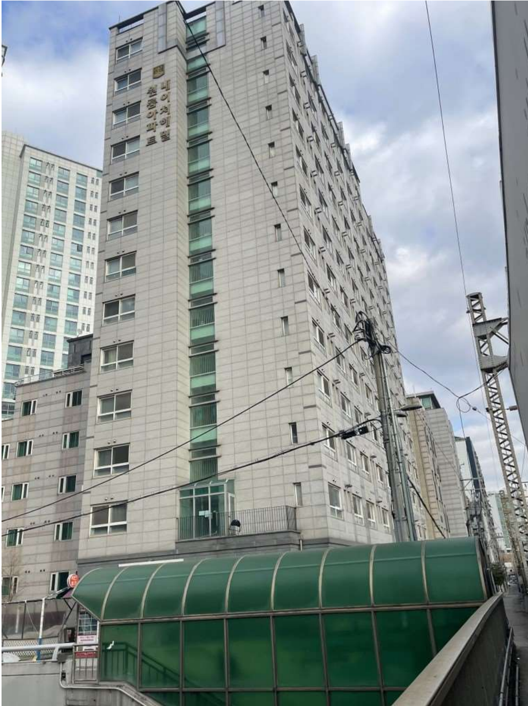
본건 소재 건물 서측 전경
