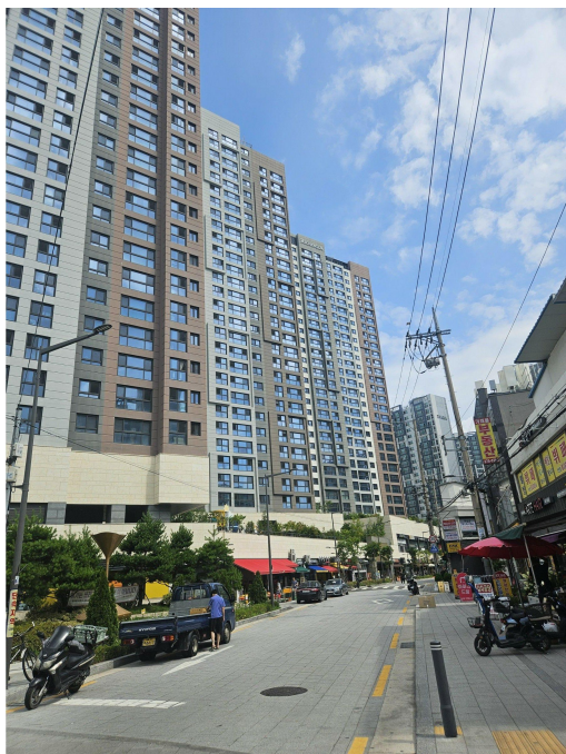
본건 및 주변 전경
