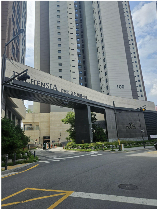
본건 주차장 입구 전경
