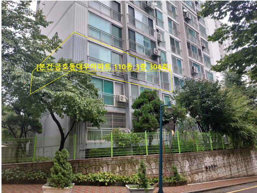
본건세대 남측 전경
