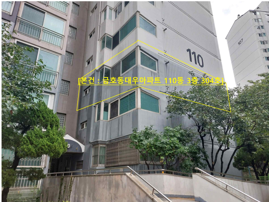
본건세대 북서측 전경
