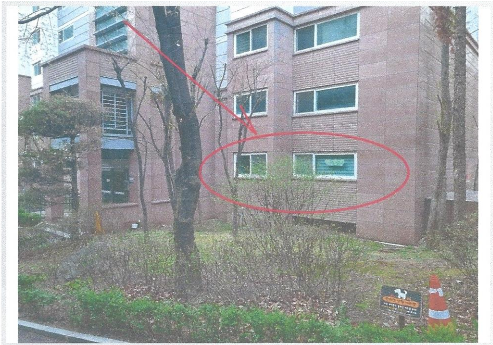
역삼이편한세상 제105동 및 본건전경(북서측에서 촬영)
