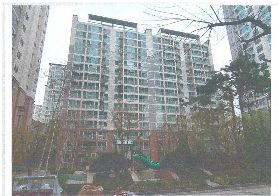
역삼이편한세상 제105동 전경(남측에서 촬영)
