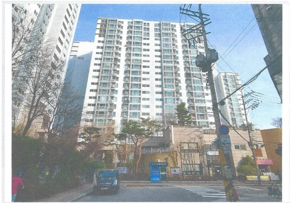
역삼래미안 제108동 및 주위전경(남측에서 촬영)
