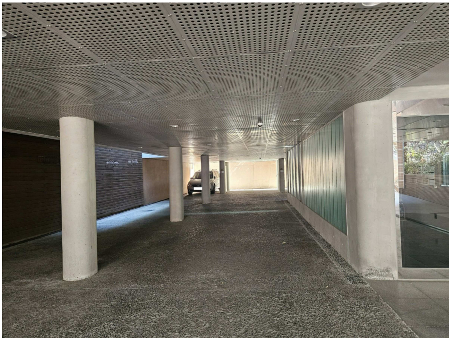
지하 1층 전경
