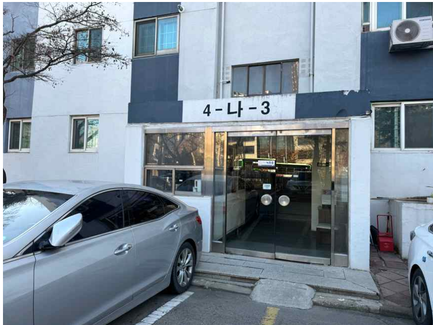
대상물건이 속한 건물의 출입구
