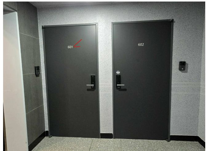
본건소재 6층 및 본건현관문 전경
