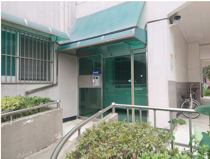
본건 1층 공동출입구 현황
