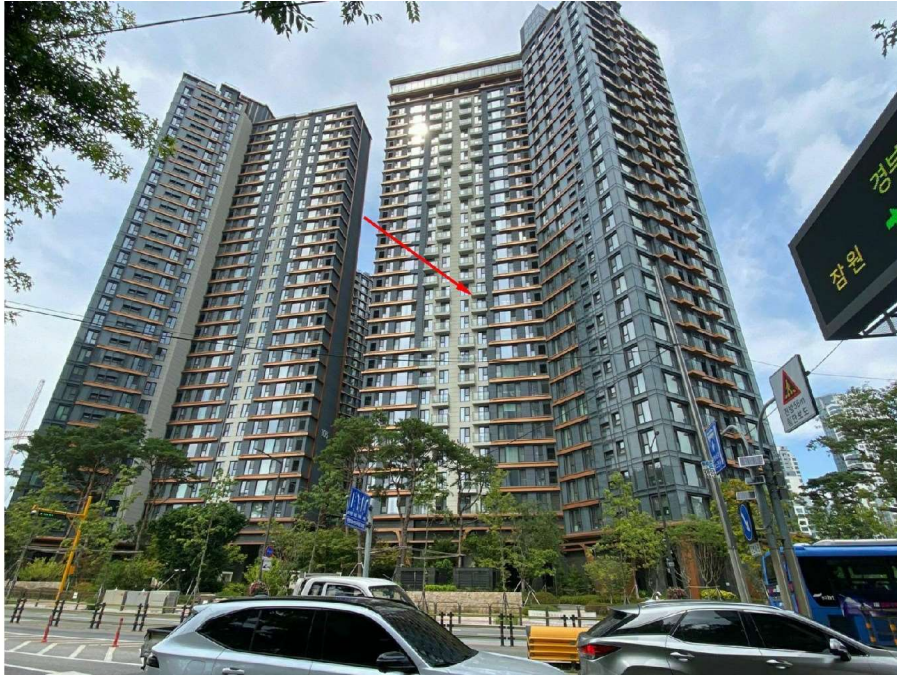
본건이 소재한 건물 전경
