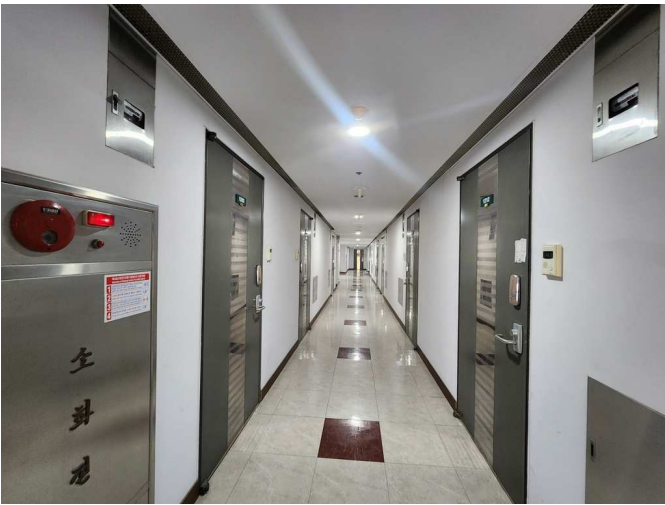
12층 복도 전경
