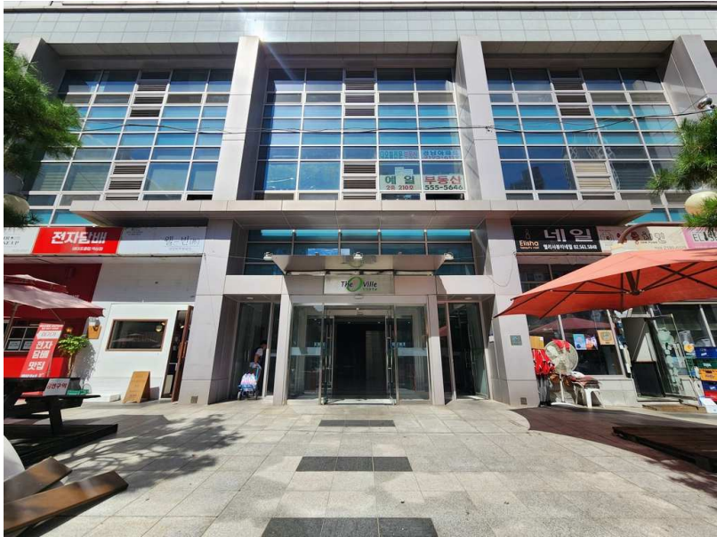
본건 공동 출입구
