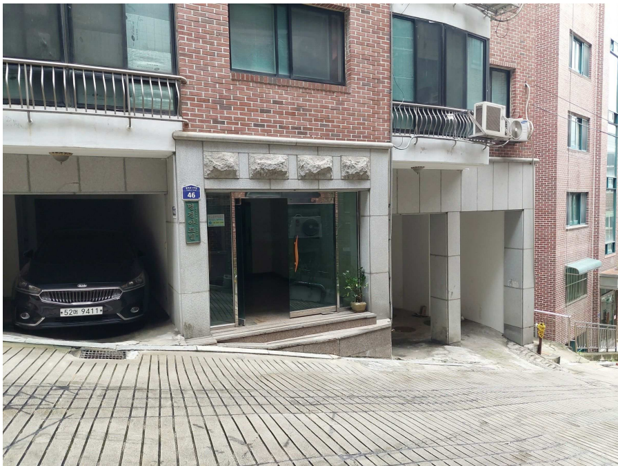
본건 1층 공동출입구 현황
