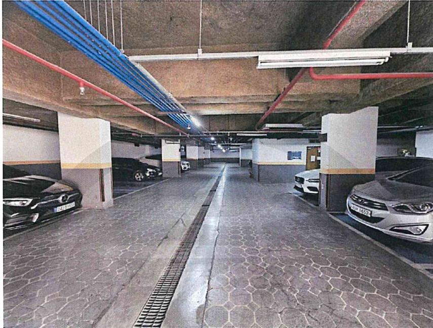
본건물내 지하주차장 전경
