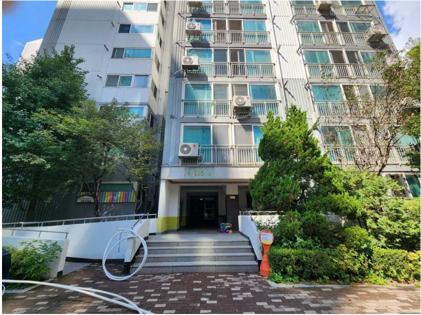
본건 1층 공동출입구
